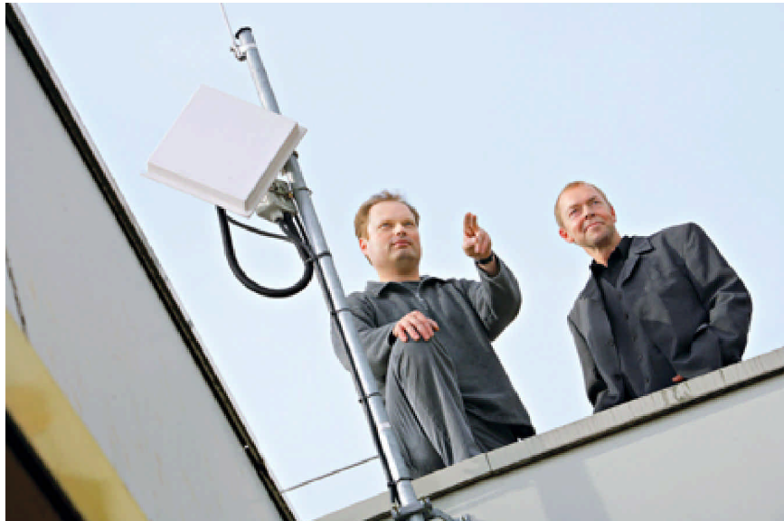
Joachim Barthel, Thomas Neumann, Technikchef der TMR: Ortsbegehung auf dem Dach des Hardeck-Hauptgebäudes
